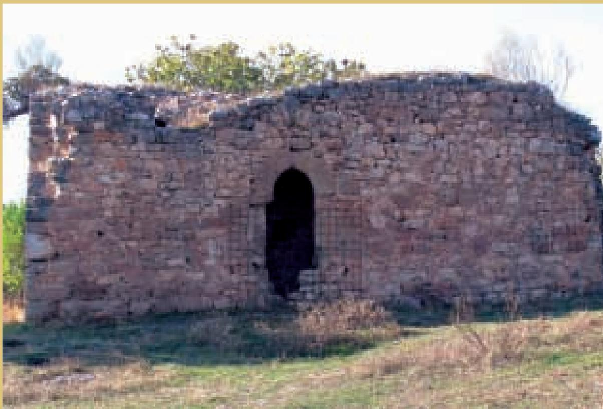
Queda en pie una torre de planta cuadrada edificada en mampostería irregular. Se accede a su interior por una puerta situada en el muro este de arco ligeramente apuntado, formado por sillares bien labrados sin clave central, que se conserva en muy buen estado.
