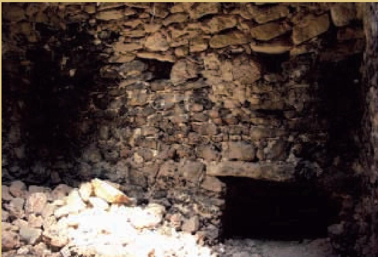
Detalles del interior de la primera planta: portillo desde donde arranca la escalera de media caracol que llega hasta la azotea donde se abren varias aspilleras a las que se accede mediante una plataforma circular y bóveda en ojiva (UJ).
