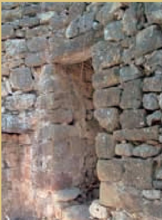
Detalles de la sala interior de la primera planta. En la primera imagen se aprecia la ventana saetera que comunica este aposento con el muro frontal de la entrada que servía para vigilar la entrada al recinto. En las otras los restos de su cubierta con cúpula de media naranja apoyadas sobre trompas. (UJ)
