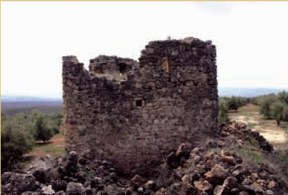
Muro norte donde se aprecia como en el resto de la torre levantada a finales del S. XIII la mampostería irregular. (UJ)
